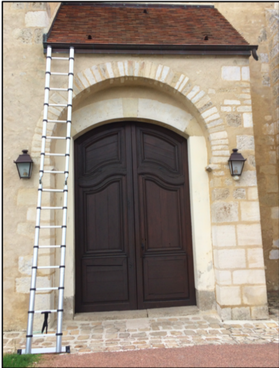
Fig. 2 – Relevé des claveaux de l'arc du portail occidental de l'église Saint-Savinien. Sens, Yonne. Photo A.-L. Morel.
